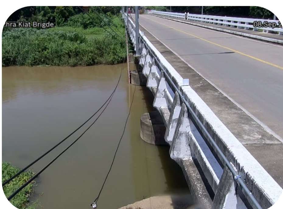
สะพานเฉลิมพระเกียรติ อ.เมือง จ.ลำปาง
